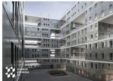
Figura 46 – Imagem de um conjunto habitacional na Espanha. Site de projetos acessado através de links do blog. Disponível em http://tinyurl.com/mrqmnt
